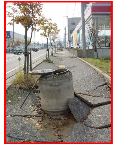
(液状化により隆起したマンホール)
