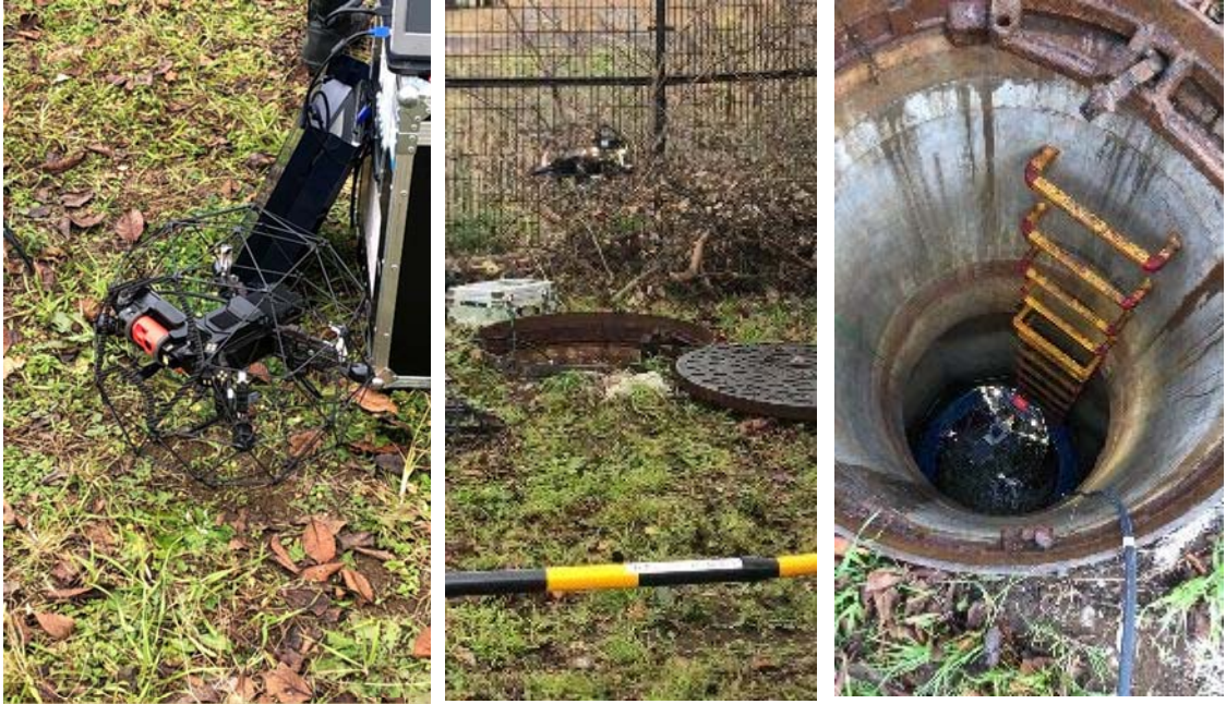
(伏越し人孔内での飛行の様子)
