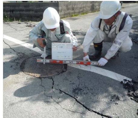
管路とマンホールの変状を測定
